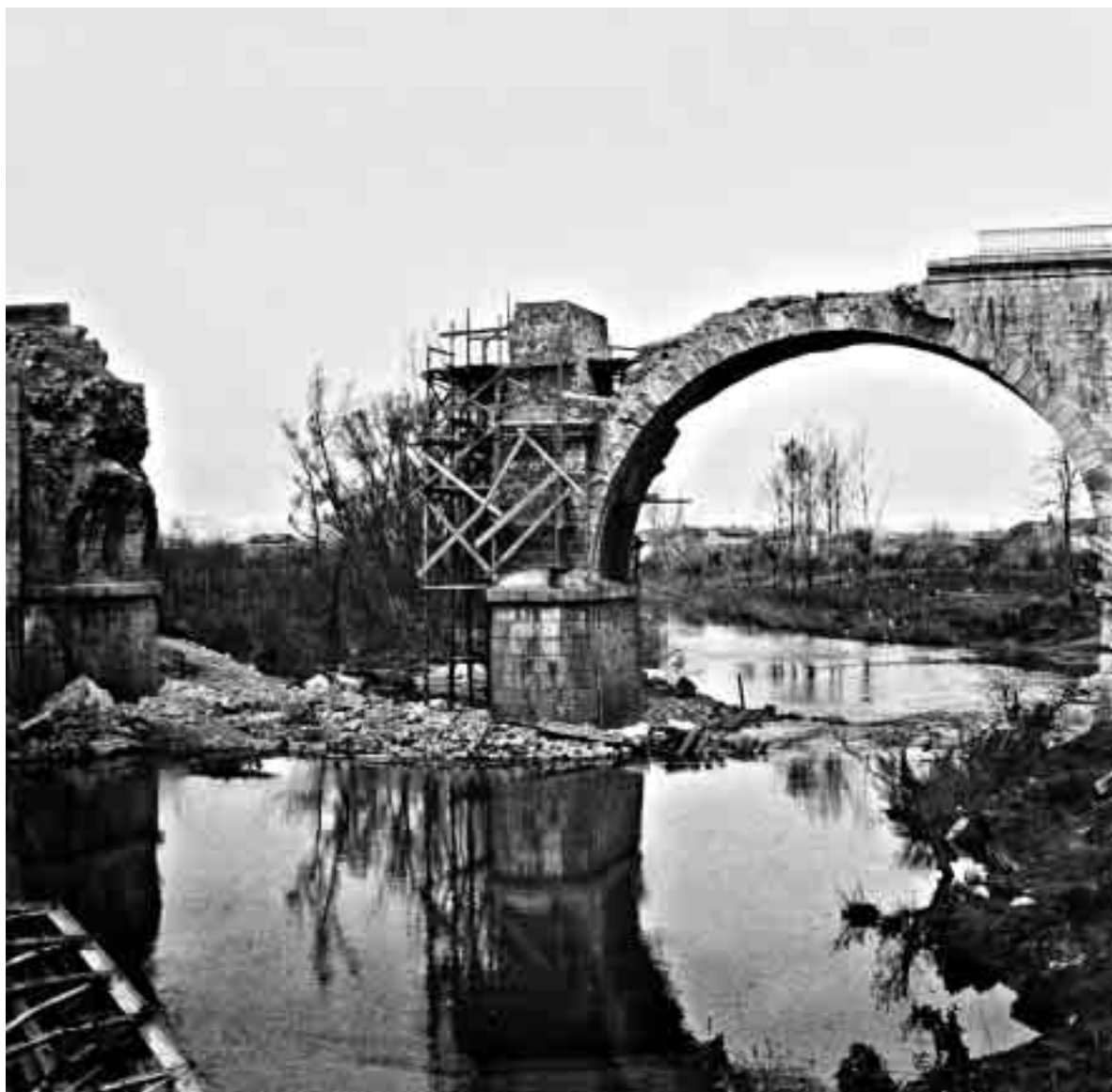
24 Aprile 1917 Rubbia. Ponte ferrovia distrutto dagli austriaci”
